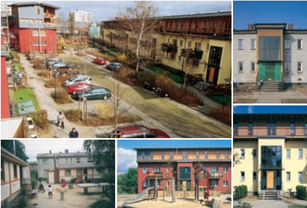
In Berlin-Lankwitz wurden verschlafene Reihenhäuser aus den Fünfziger Jahren aufgestockt. So entstand ein farbiges neues Stadtquartier.
