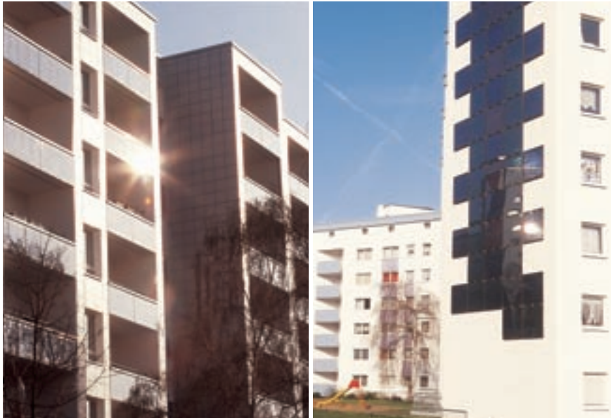
Die Entwicklungsgesellschaft Ecofys hat Fotovoltaik-Module vorbildlich in die Fassaden zweier Wohnhochhäuser aus den Sechziger Jahren integriert.
