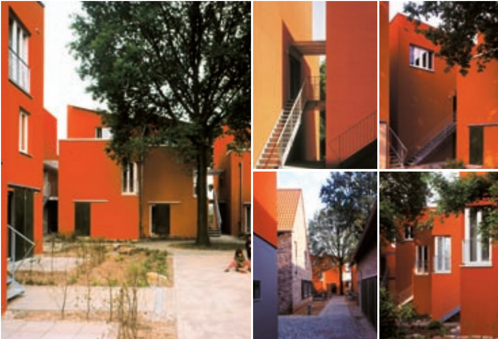
Einen alten Bauernhof mitten im Ort verwandelte der Neusser Bauverein in eine neue Wohnanlage mit gemeinschaftlichem Leben für Jung und Alt.
